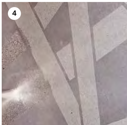
4 仕上げ面を圧水洗浄します。
