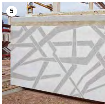
5 洗い出された面とのコントラストでパターンが浮かび上がります。
