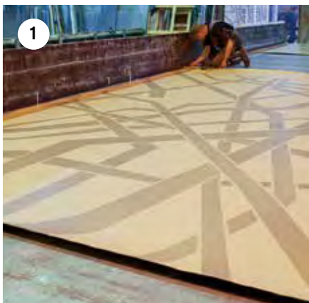
1 グラフィックコンクリートシートを型枠に敷き込みセットします。
